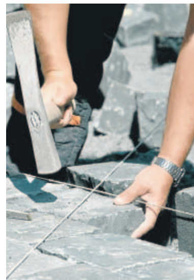
Auch im Bauhauptgewerbe hat sich die Lage stabilisiert
